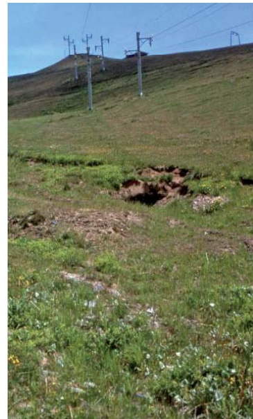
Bleibenden Erosionsschäden in Folge von Planierungen, trotz Begrünung (Cry d'Er, Montana VS)
